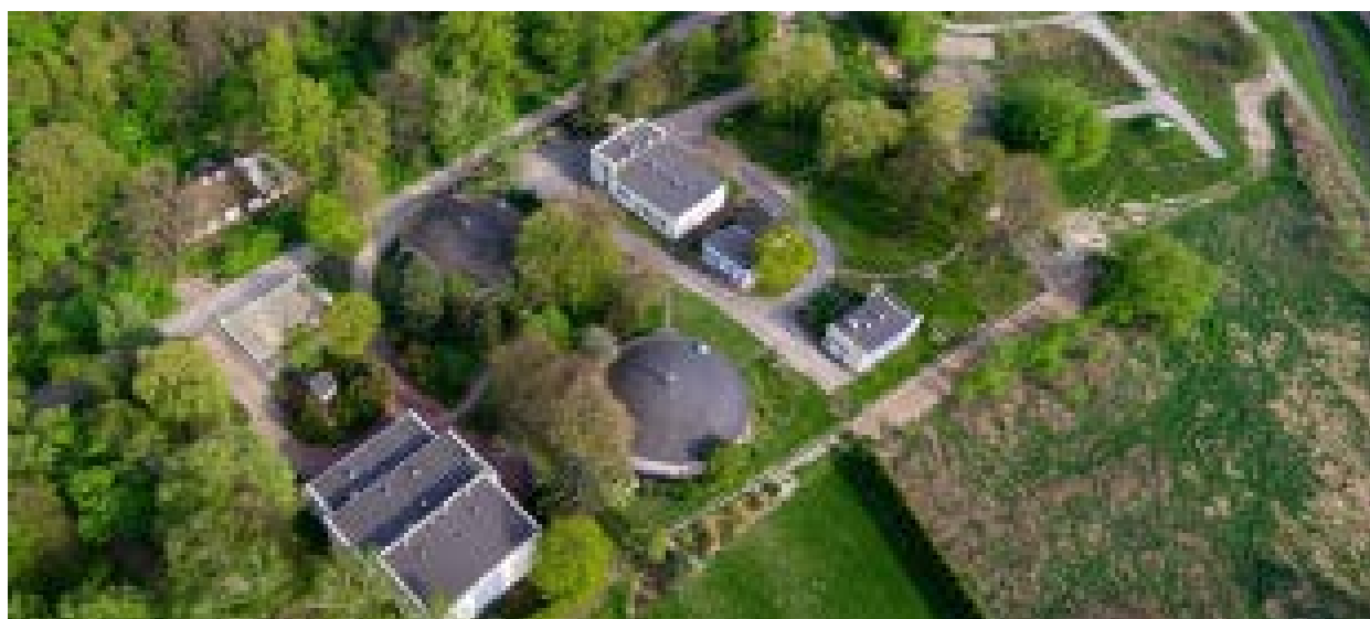
Stacja wodociągowa „Sławinek”, Lublin
